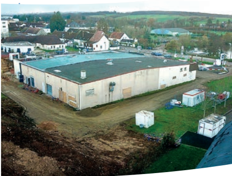
Le bâtiment dans sa phase de désamiantage avant travaux
