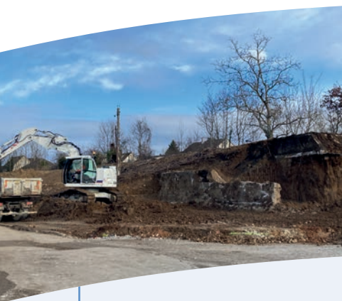
Travaux d'aménagement des abords et création d'une aire de manœuvre à l'arrière du bâtiment
